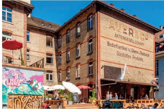
Das Gebäude am Sihlquai 131 mit dem Impact Hub als Mieter wird abgerissen.
